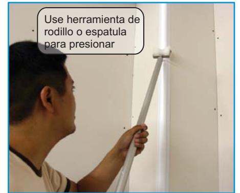
Instale esquinero después de haberle agregado el compuesto
