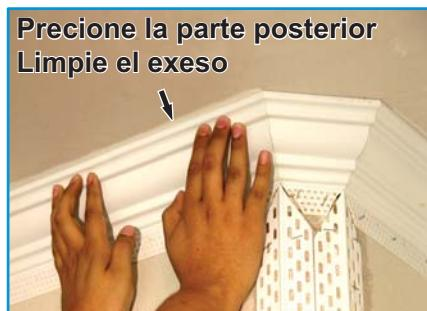
3er Paso: Aplique una capa de 1/2" de pegamento siliconizado pintable de alta calidad, como el silicon 700/710 de Trim-Tex o Big Stretch marca sashco a la parte superior de la molduradecorativa. Aplique pegamento en aerosol 847 a la extremidad perforada.
