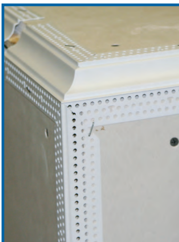
Esquina Exterior de 90°
